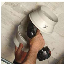
Закрепите основание вентилятора.
