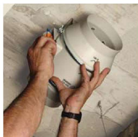
Установите корпус вентилятора.
