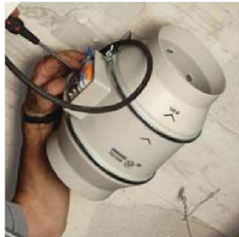
Подключите вентилятор к сети электропитания.
